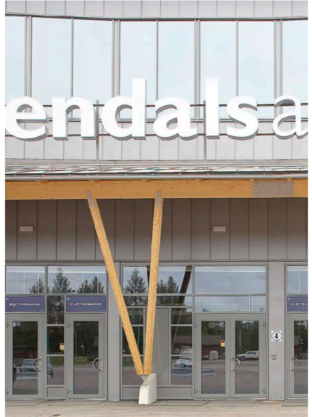
Ejendals Arena i Leksand.
