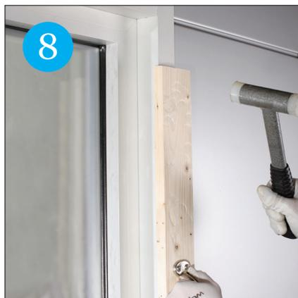
8 Applicera fogmassa på fodrets fläns eller direkt på panelerna. Slå invändiga foder på plats. Använd alltid ett tryckutjämnande underlag, t.ex. en träbit.
